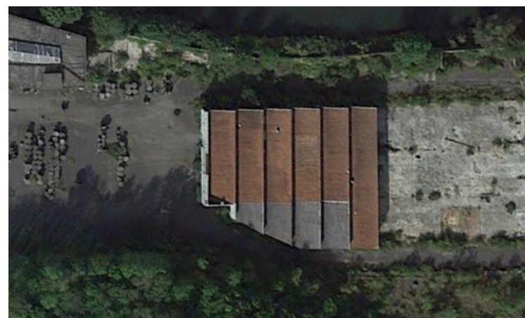
VUE AÉRIENNE DU BATIMENT A DEMOLIR
